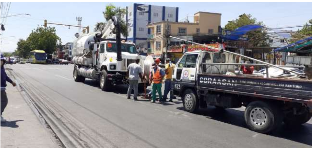
Fuente: Dirección Aguas Residuales, Corporación del Acueducto y Alcantarillado de Santiago (CORAASAN).
